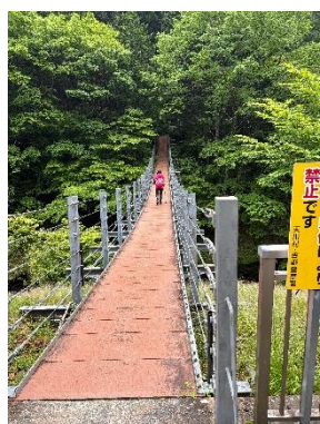
登山口の吊り橋
