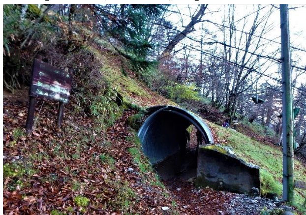
【リフト下のトンネル】
