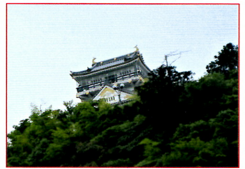
④ (山腹から見上げた岐阜城)
